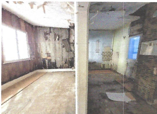
Kein sonderlich einladender Anblick: Unter mancher Tapete im Seitenflügel des ehemaligen Dompfosten-Gebäudes befinden sich bis zu 15 weitere Schichten. BILD: GEORG LANGE
